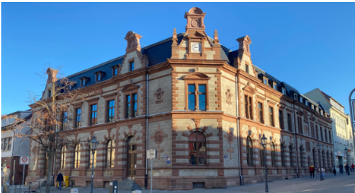
Im frisch renovierten ehemaligen Postamt befindet sich die neue MVZ-Betriebsstätte in Bernburg.
