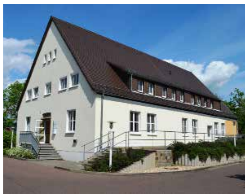
Danach zog die Krankenpflegeschule in das sanierte Gebäude des früheren Kinderhospitals.
